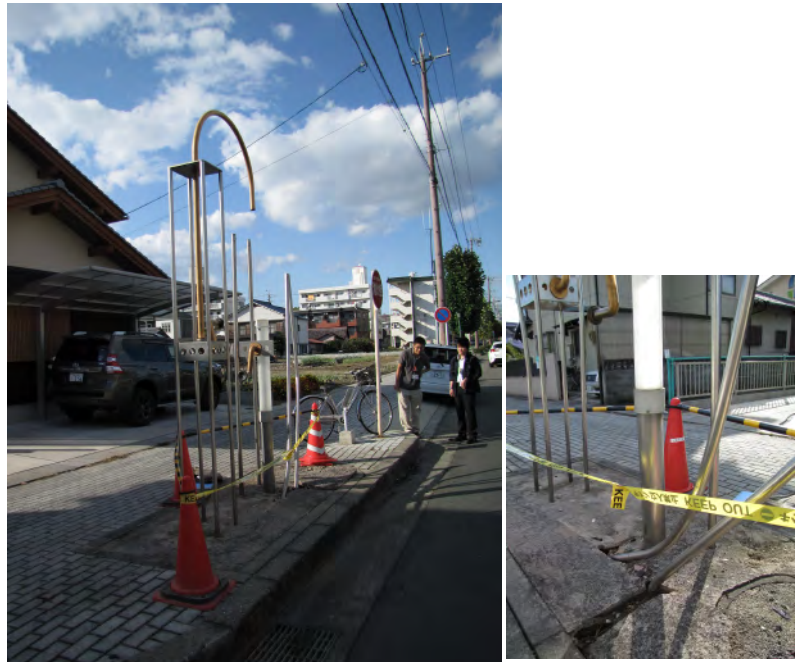
2015/10/13 事故による破損状況確認
