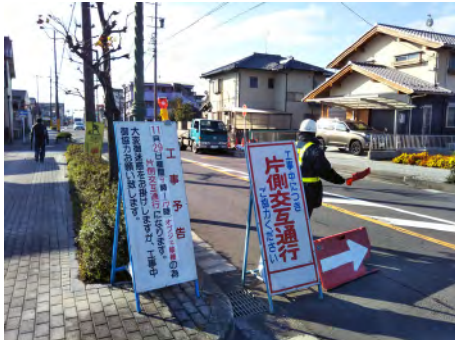
2016/11/29 再生利用可能部分を検証する為、破損物回収
