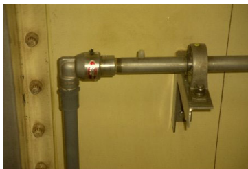
回転するパイプの所々に付けられたノズルから栽培溶液を、根に霧状の散布する
